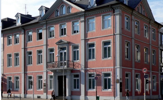
Modernste Medizintechnik in den historischen Mauern des Praxisgebäudes
